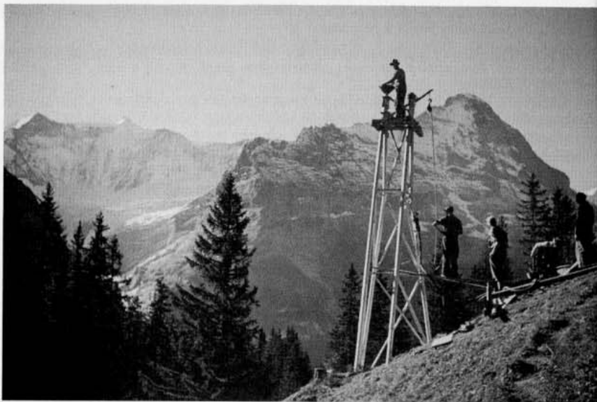
Herbst 1946 – 2. Sektion, Ausbetonieren der Mastrohre
